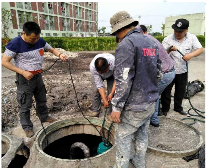
水电中心和学生社区协同做好水泵维修工作
