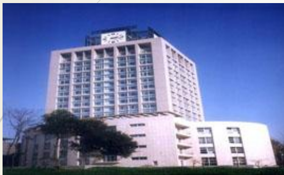
工科大楼（鲁班奖）
